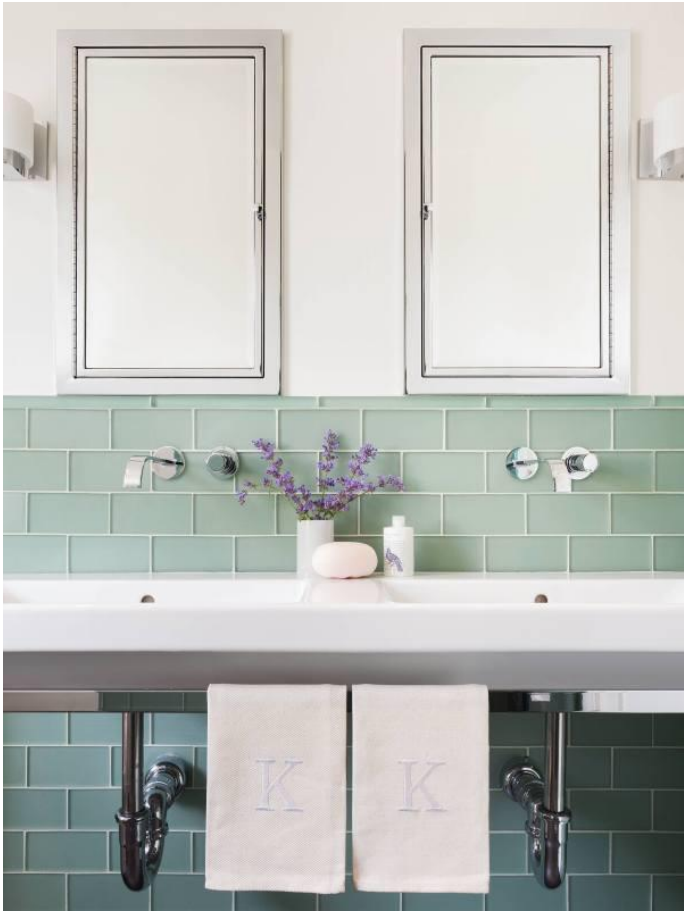
下方瓷砖美缝，上方防水漆
